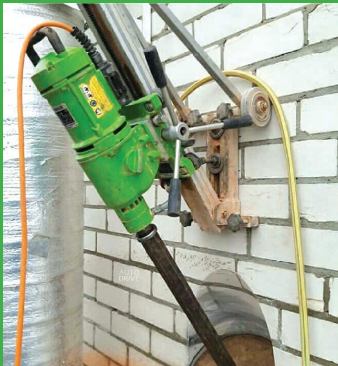
Сверление кирпичной стены под углом
