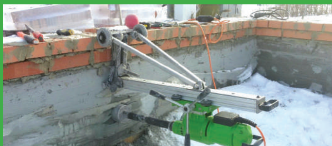
Сверление железобетонной стены
