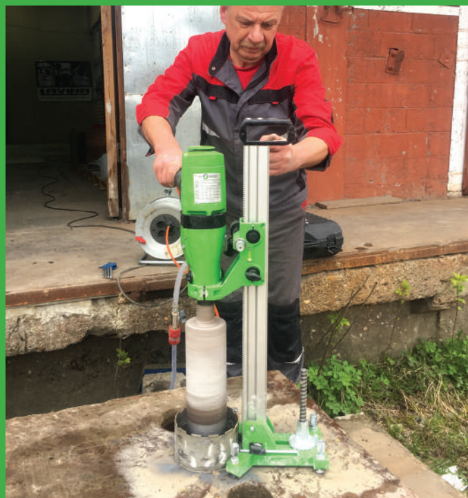
Вертикальное сверление железобетона
