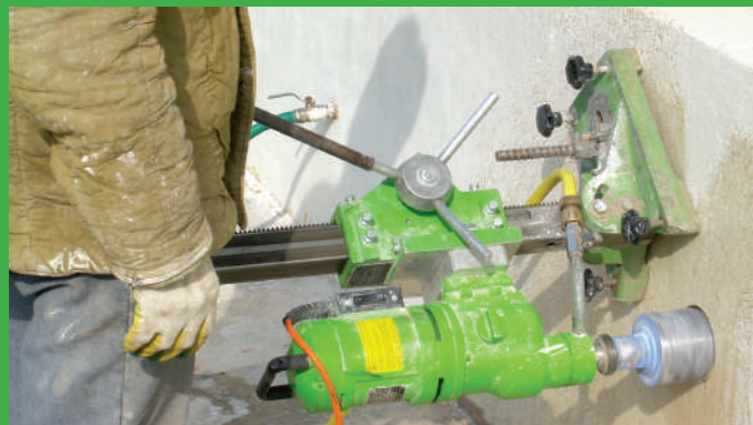
Горизонтальное сверление железобетона
